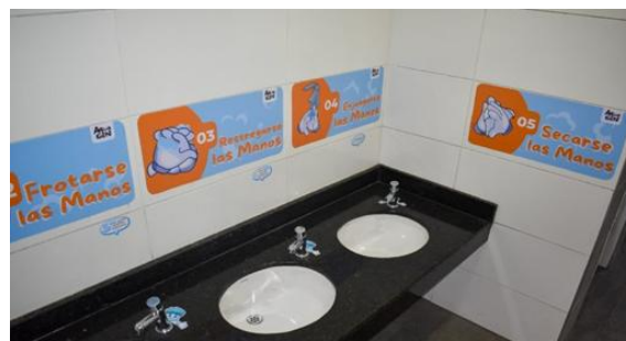
Imagen 3. Remodelación baño de colegio
