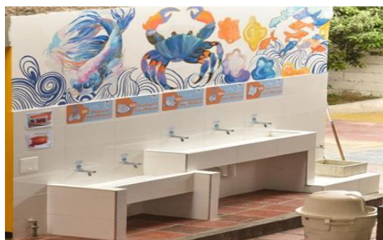
Imagen 4. Remodelación baño de colegio
